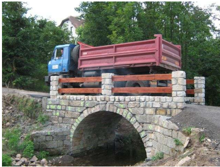
Zatěžkávací zkouška mostu proběhla úspěšně.
