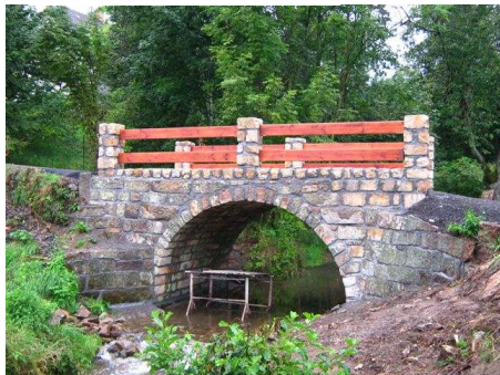
Oprava mostu u bývalého mlýna.
